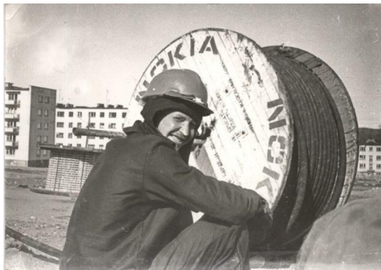
Боец стройотряда Вадим Шишкин летом 1981-го года в городе Никель тянет электрический кабель к новостройкам
